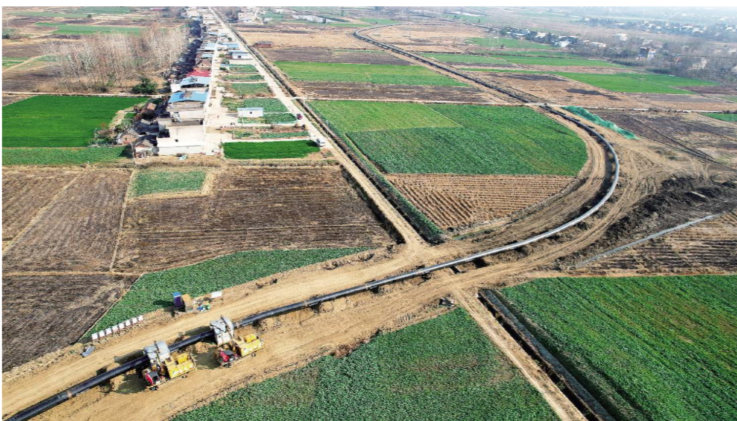
图为正在建设中的西气东输天门黄潭段主体管道。
